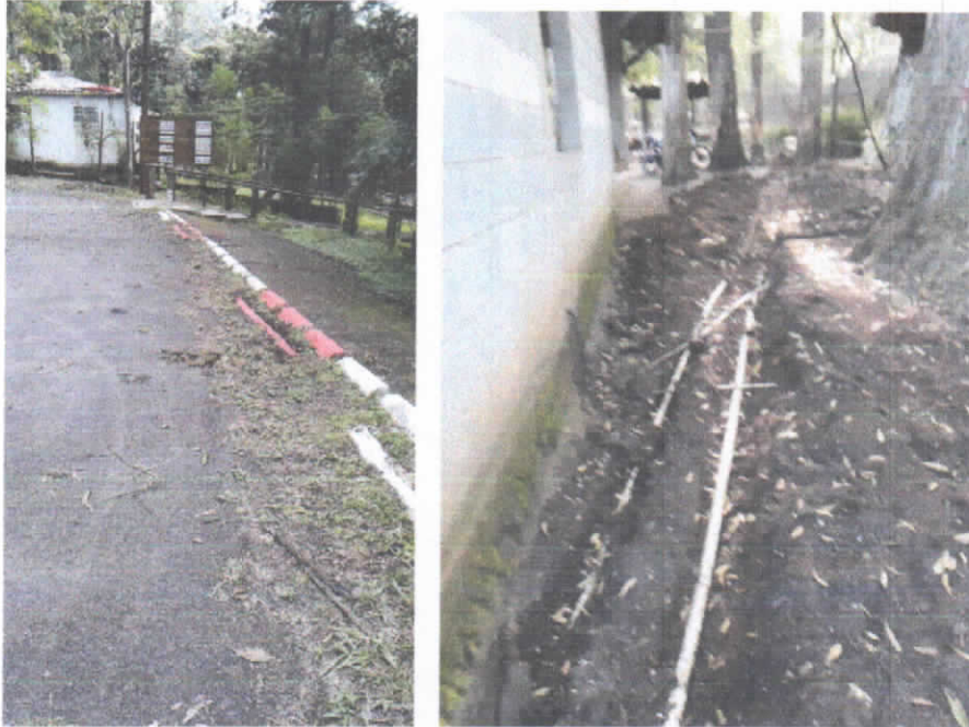
(foto 17 y 18) Areas de limpieza. Reparación de tubería
