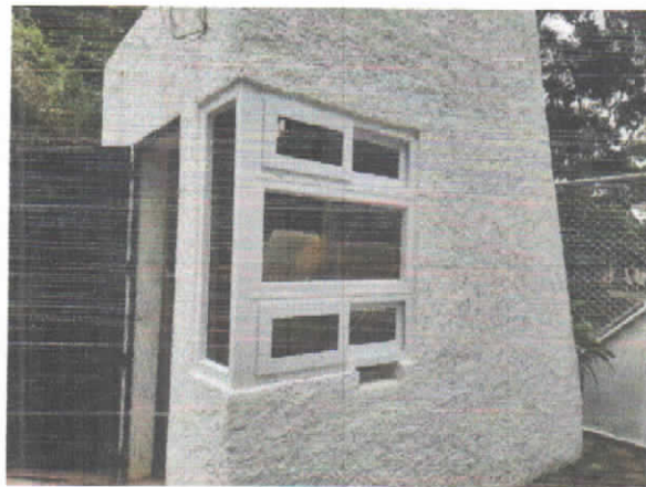
(foto 14) Ventanal de ingreso en garita reparado
