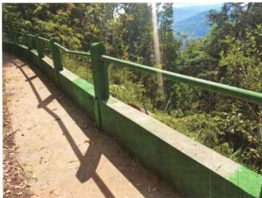
Foto 36 - 40: Trabajos de mantenimiento varios durante el mes.
