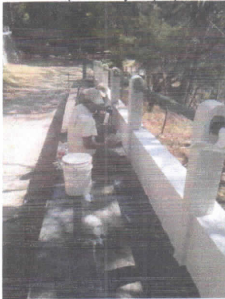
(foto 23 y 24) Aplicación de pintura en baranda de mirador y caleado de bordillos.
