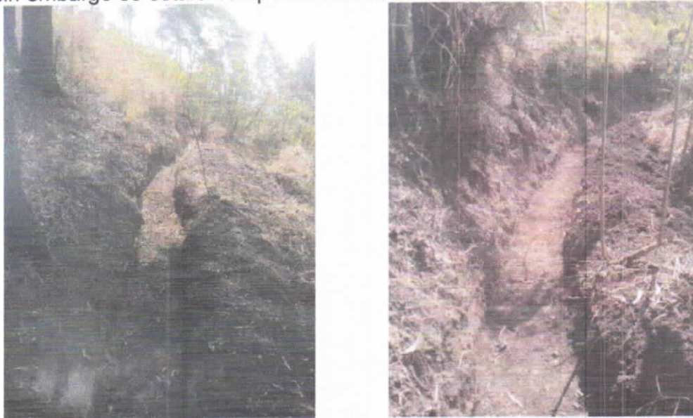
(foto 9 y 10) Estructuras de conservación de suelos con mantenimiento.
