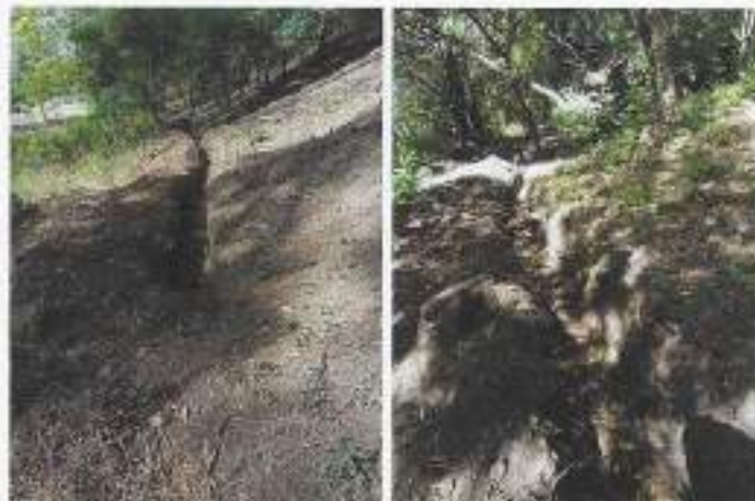
Foto 13 y 14. 2 hectáreas implementadas con nuevas acequias reduciendo erosión en brechas cortafuegos.
