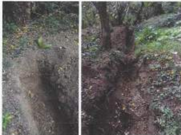
Foto 11 y 12. Estado actual de las acequias con mantenimiento.
