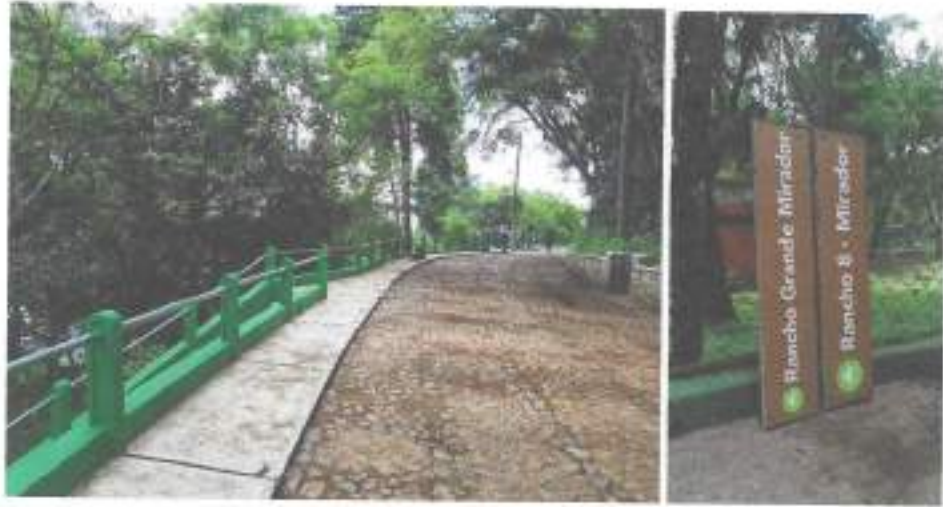
Fotos de mantenimientos descritos anteriormente.
