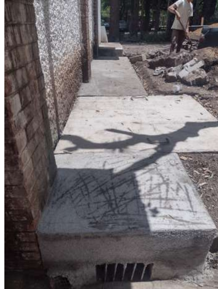
Mantenimiento de jardines, construcción de pozo de absorción y banqueteta
