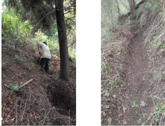
Foto 9 y 10, Mantenimiento de acequias.
