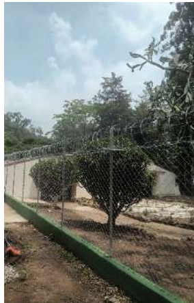
Foto14 y 15, Instalación de alambre razor perimetral, para seguridad de oficinas.
