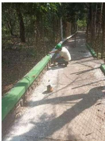
Foto 15 y 16, Aplicación de pintura a canchas y bordillos.
