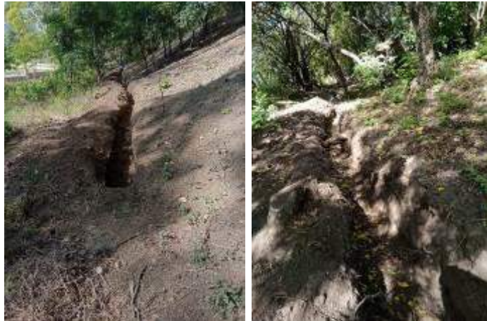
Foto 11 y 12: 2 hectáreas implementadas con nuevas acequias reduciendo erosión en brechas cortafuegos. (fotografías de diciembre 2023)
