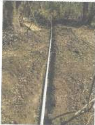
(foto 14 y 15) Instalación de tubería nueva, para conducción de agua potable a miradores.
