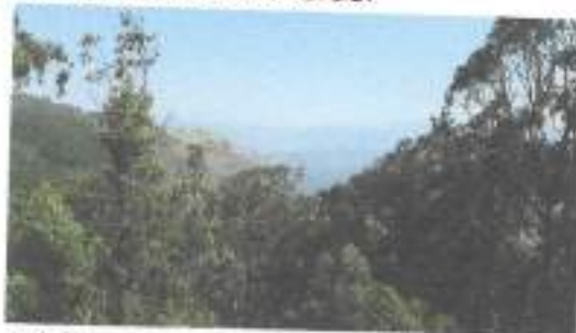
(foto 13) Monitoreo por medio de la torre de control.
