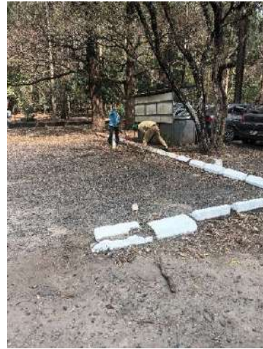
Foto 15 y 16, Aplicación de pintura a bordillos.
