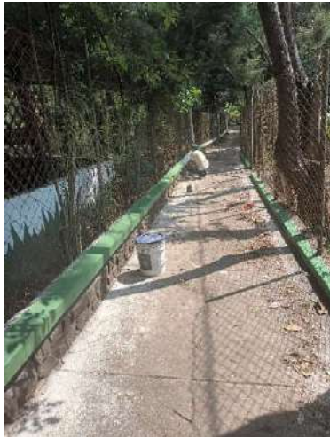
Foto 15 y 16, Aplicación de pintura a bordillos.
