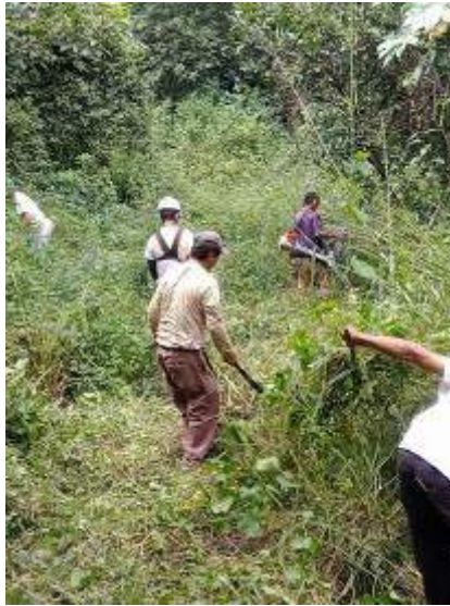
Foto 5: Área con mantenimiento (fotografía de octubre 2023).
