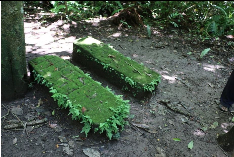
a) Soportes del Altar 1 de Piedras Negras, erosionados. Yacen al pie de la Estructura J-4 sin ningún tipo de protección. Fotografía de la autora.
