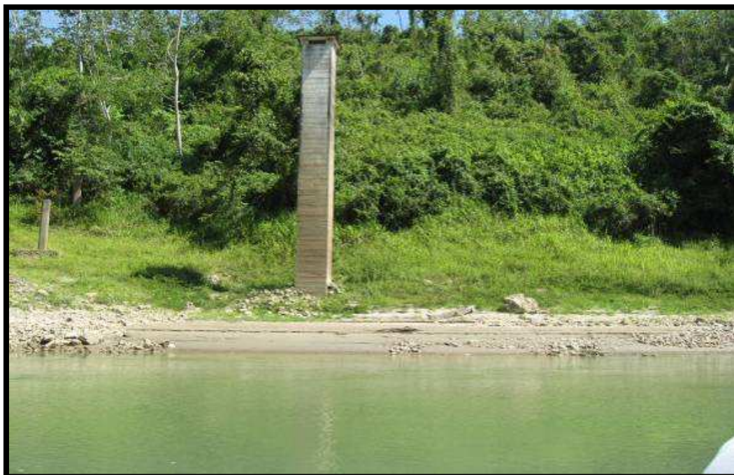
Fotografía No. 13 Torre de Control, puesto Yaxchilán Campamento, Control Profundidad, Río Usumacinta.
