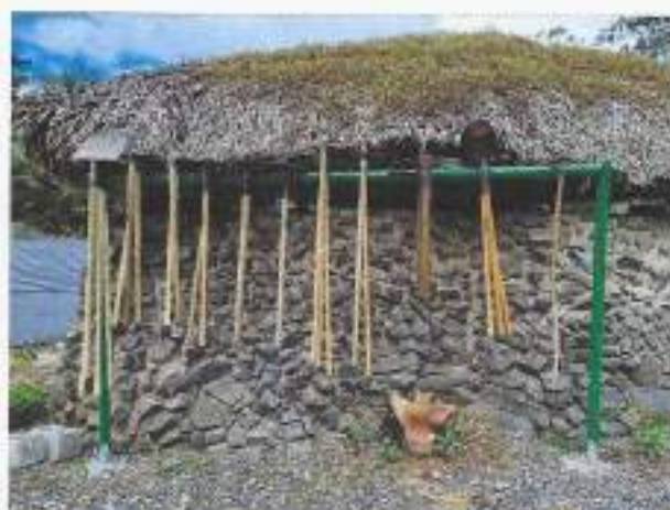
Foto 15, 16, 17, 18 y 19. Mantenimientos descritos anteriormente.
