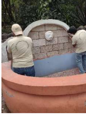
Foto 13 y 14, Reparación de cernido de búcaro de Plaza Antigua y pintado de bancas.
