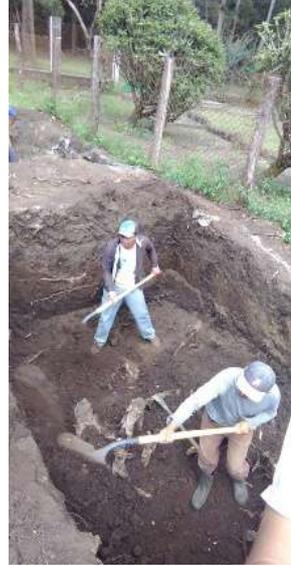
Foto 21 y 22, Chapeo de áreas verdes y perforación de pozo de infiltración.
