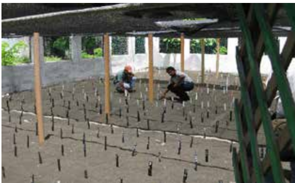
El Tortugario Monterrico, construido con paredes y columnas de block y malla con sombra de saran y estacas de PVC.
