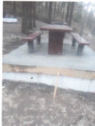
(foto 19 y 20) Reparación de piso de mesa, de uso público.
