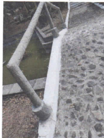
(foto 21 y 22) Construcción de lavamanos y reparación de bases de baranda de puente.
