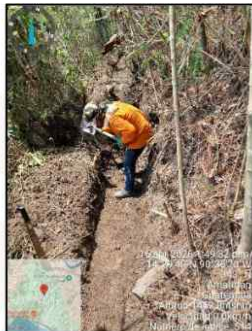
FIGURAS 12-26. Trabajos de mantenimiento de acequias de ladera en el mes de abril 2026.
