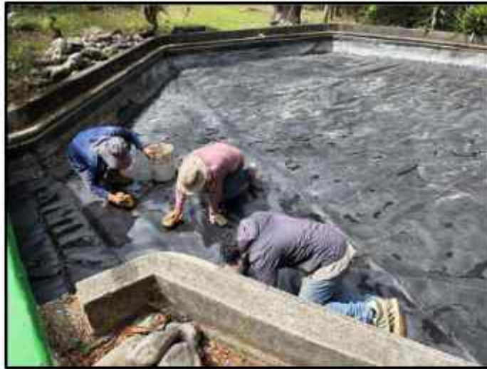
FIGURAS 35-37. Trabajos de mantenimiento varios durante el mes.
