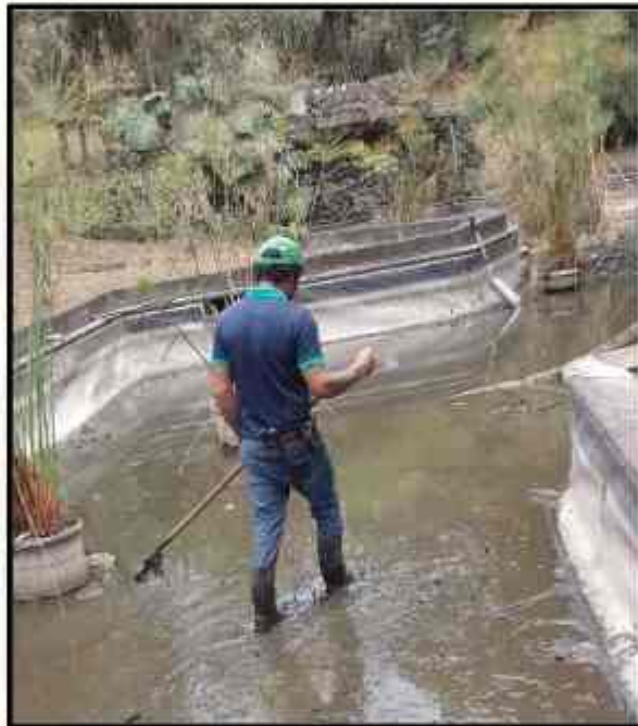
FIGURAS 38-41. Trabajos de mantenimiento varios durante el mes.
